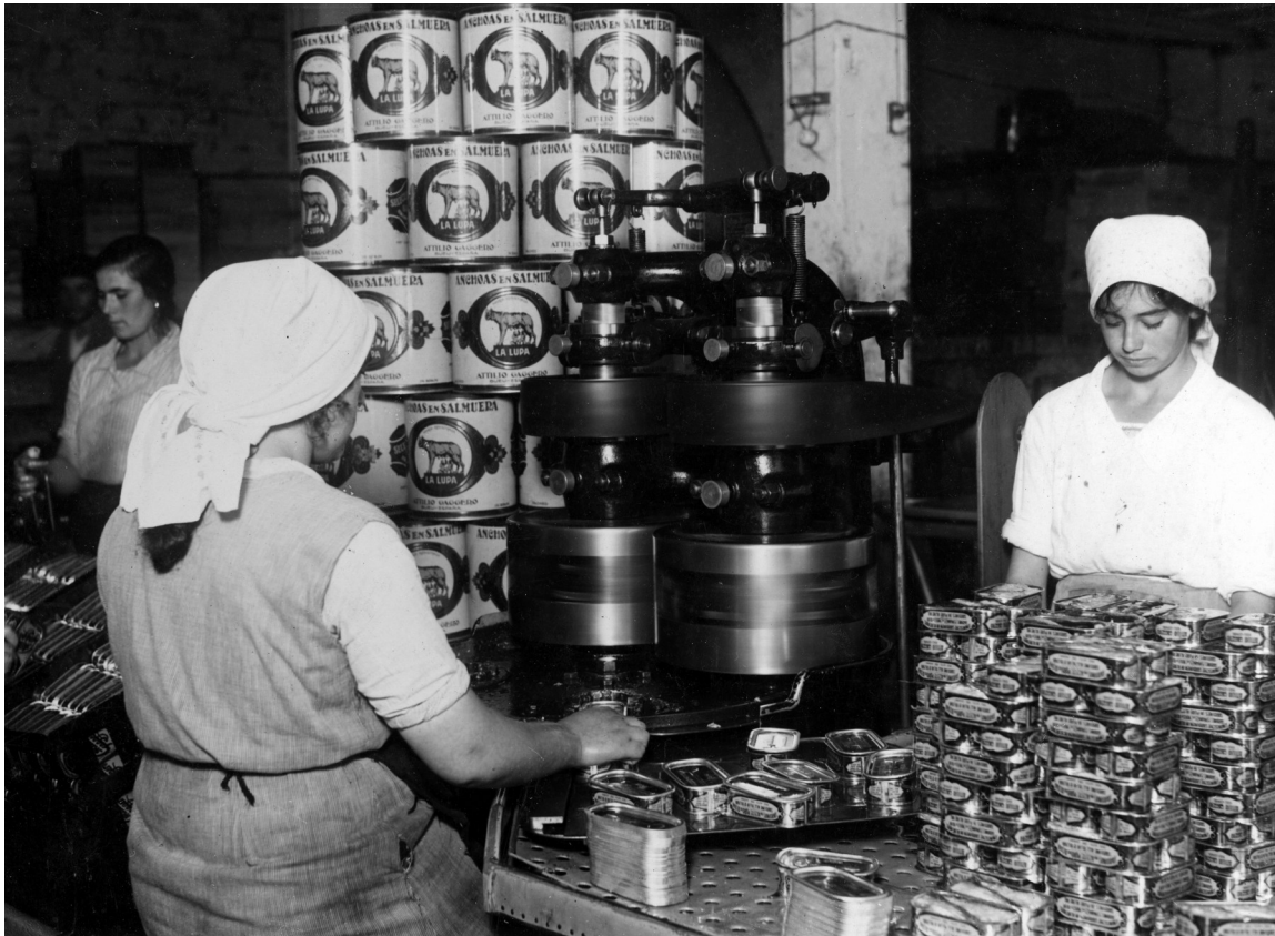
Cadea de traballo nas máquinas pechadoras de latas da fábrica, contra 1970. Arquivo Attilio Gaggero-015
